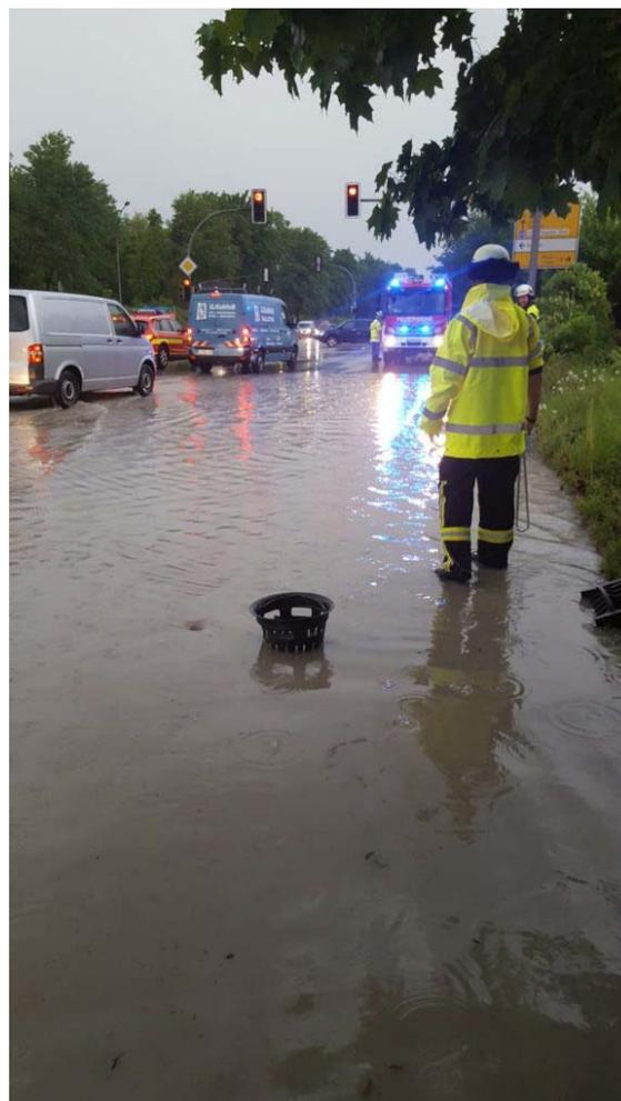
Ein Einsatzfahrzeug, das eigentlich zu einer anderen Einsatzstelle alarmiert wurde, leistete Hilfe und sperrte die Abbiegespur an der Ernst-Hilker-Straße in Fahrtrichtung Lemgo. Grund für die Überschwemmung war ein verstopfter Gully. Dieser wurde von Schmutz befreit, so dass das Wasser ablaufen konnte.
